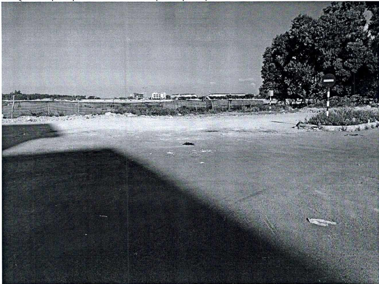
RA QUÂN DỌN DỆP RÁC THẢI XÂY DỰNG TẠI TRỤC ĐƯỜNG TỔ HỮU THÔNG RA VICOLAND
