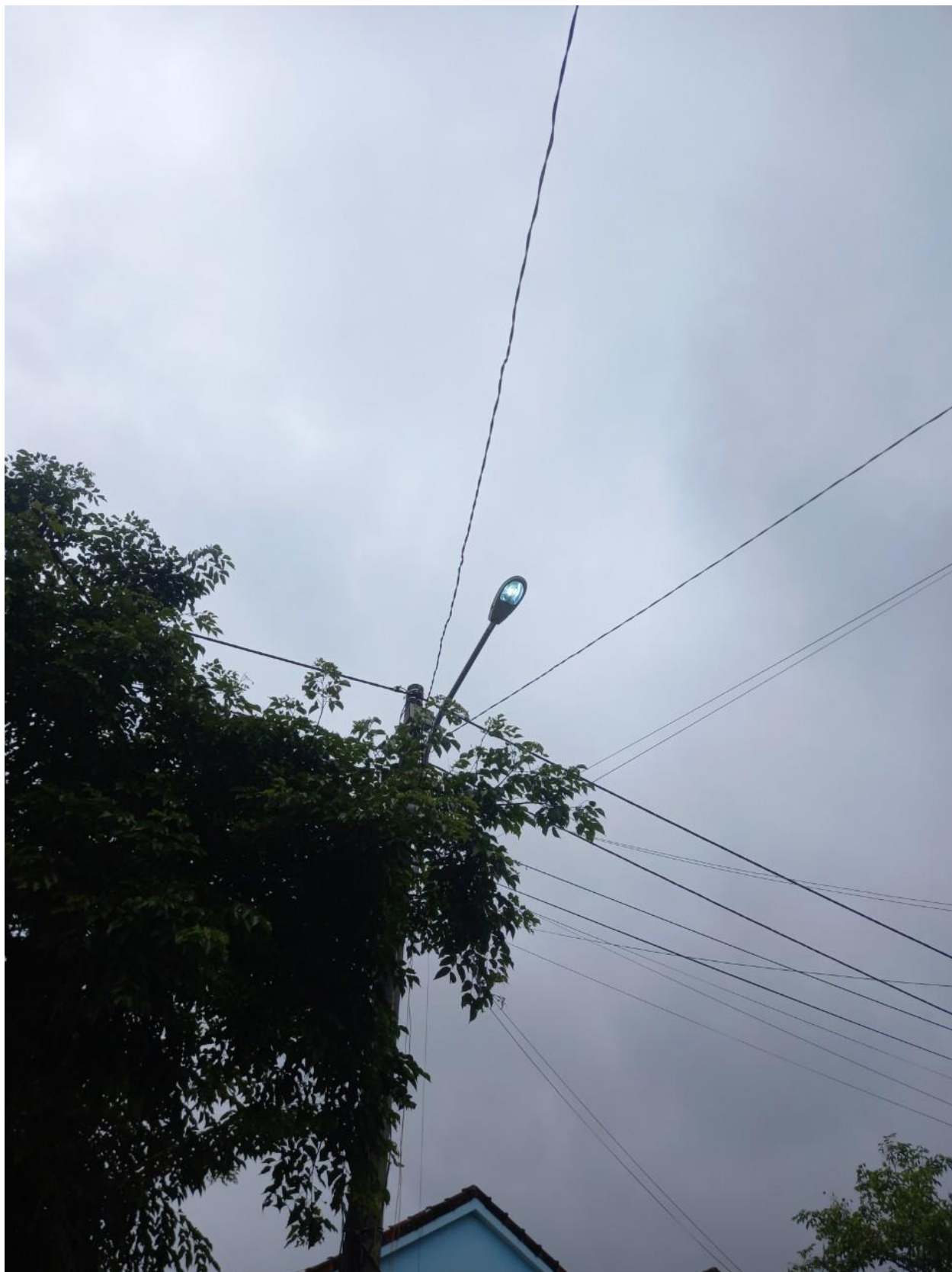
Hình ảnh hệ thống đèn chiếu sáng công cộng tại thôn Cao Đôi Xã, xã Lộc Trì sau khi đã sửa chữa xong
