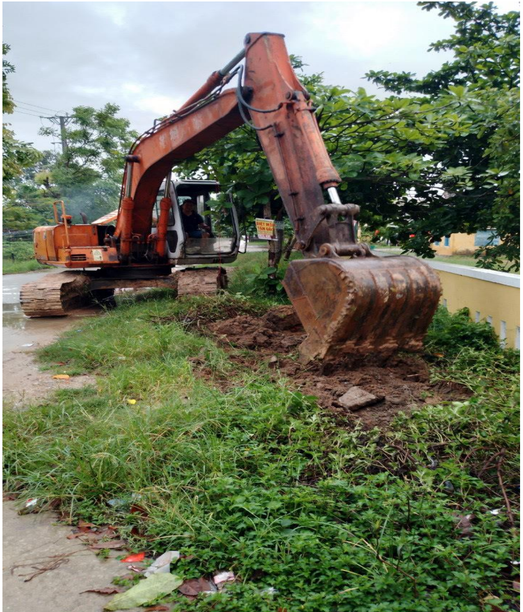
Một số hình ảnh nhà trường khơi thông vị trí thoát nước ngoài tường rào
