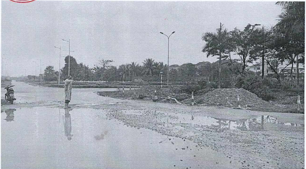
VÍ TRÍ ĐIỂN HÌNH ĐÃ THI CÔNG XONG CHƯA HOÀN TRẢ MẶT BẰNG
