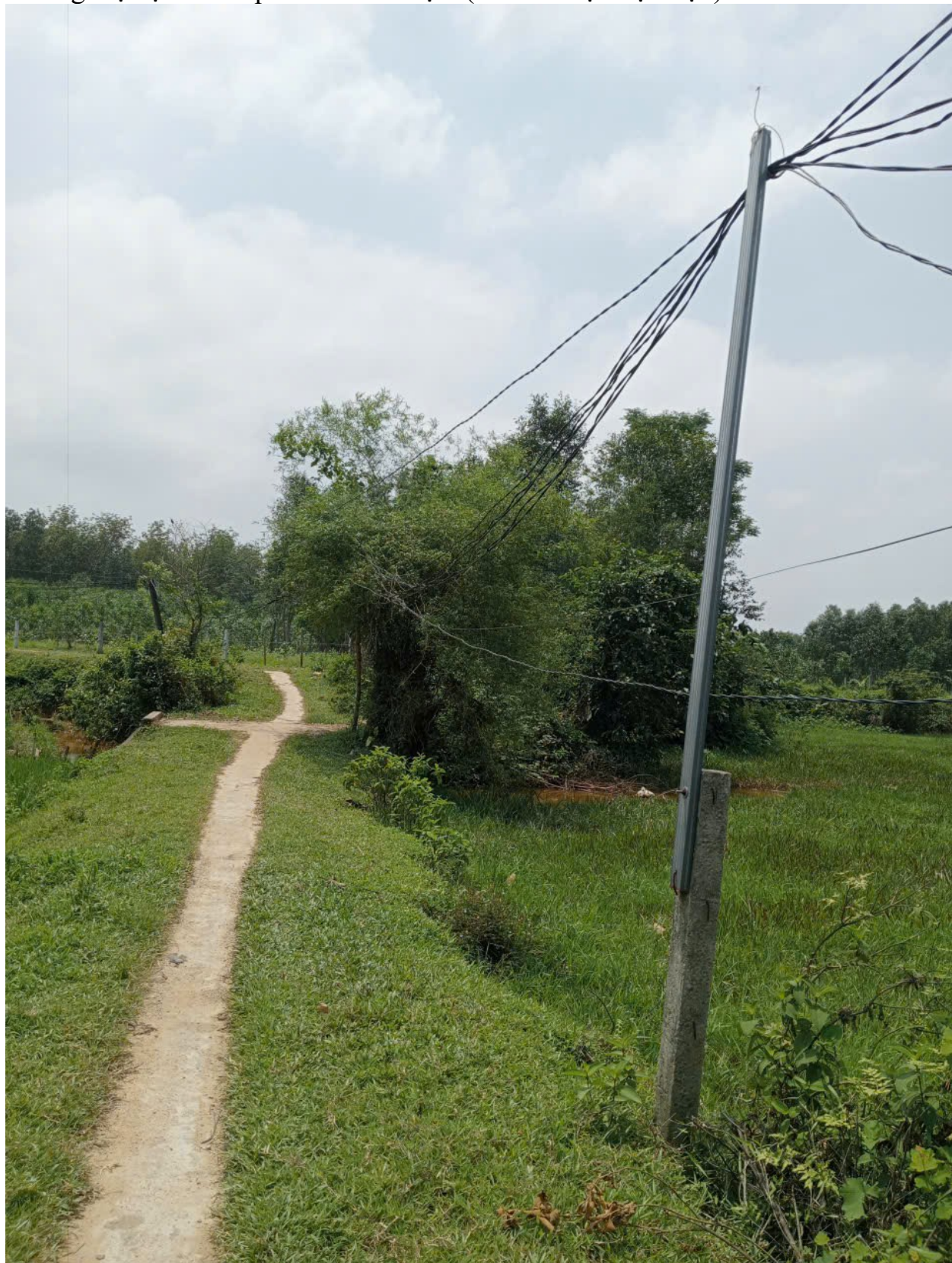
Đường kiệt tại tổ dân phố La Khê Trẹm (chưa có cột điện Lực)
