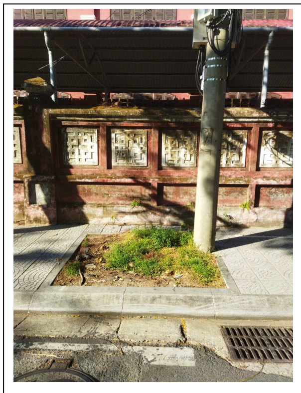
Ô kê cây Phượng đỏ số hiệu 33 đường Phan Bội Châu cột điện nằm trong ô không đúng quy định
