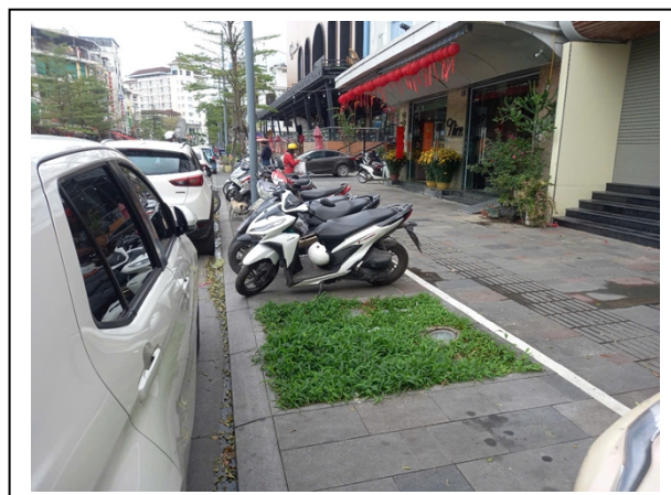
Ô vướng đường ống điện trước số nhà 31 Hai Bà Trưng
